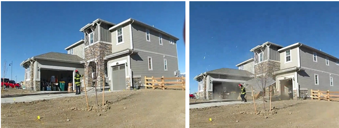
Photo : Ces photos ont été prises quelques secondes avant la déflagration. Aucun signe extérieur de défaillance n'était visible.
